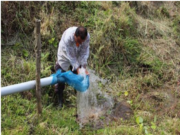
Fig. N° 27. Entradas de agua
